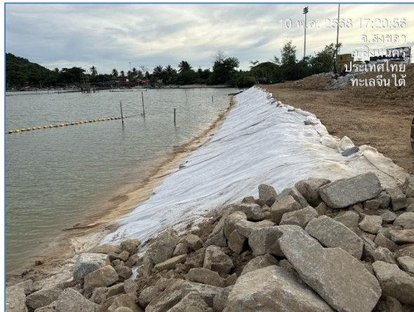
รูปที่ 2.2.2-1 การปูแผ่น Geotextile และม่านกันตะกอนบริเวณพื้นที่ถมทะเล
