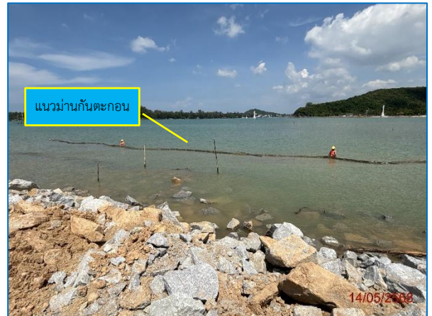
รูปที่ 2.2.2-1 การปูแผ่น Geotextile และม่านกันตะกอนบริเวณพื้นที่ถมทะเล
