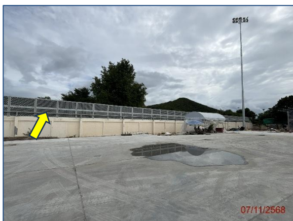
รูปที่ 2.2.2-14 กำแพงกันเสียงด้านที่ติดกับบ้านหน้าหลา
