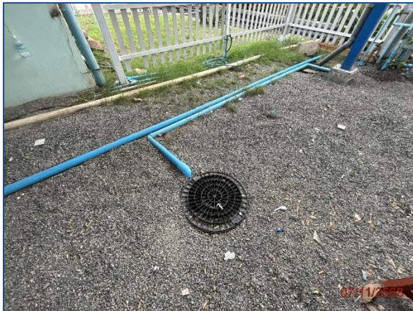
รูปที่ 2.2.3-11 ถังบำบัดสิ่งปฏิกูลจากห้องน้ำ
