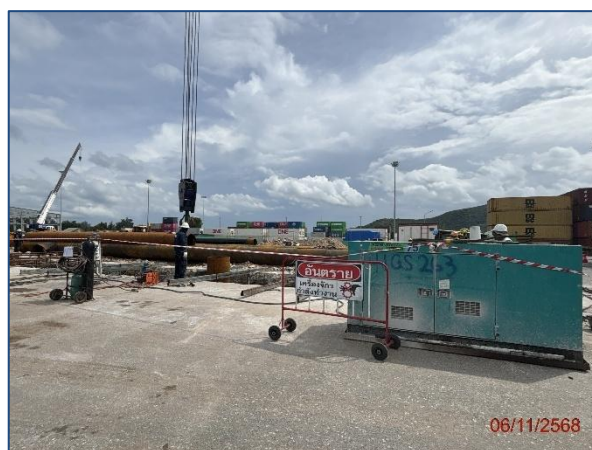
รูปที่ 2.2.2-41 การกั้นพื้นที่ทำงานขณะเครื่องจักรทำงาน
