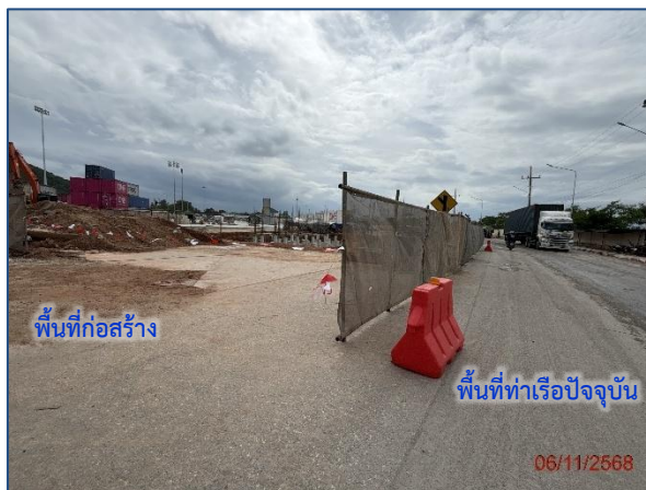
รูปที่ 2.2.2-2 แนวกำแพงกันระหว่างพื้นที่ถมทะเลและพื้นที่ปัจจุบันของท่าเรือ
