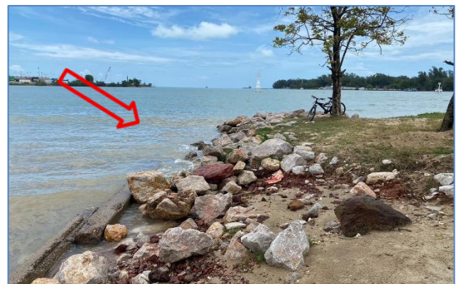
รูปที่ 3.3.1-11 แนวป้องกันการกัดเซาะแบบกองหิน ทั้งตามแนวชายฝั่ง (ภาพถ่ายพื้นที่จริง)
